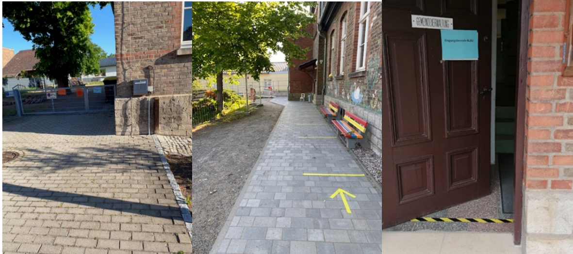
Flurbereich sowie Gruppeneingangstür
