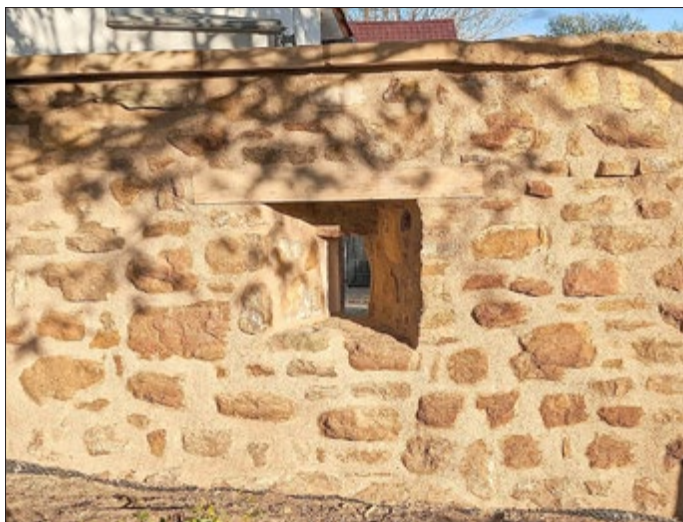
Zustand nach der Sanierung
