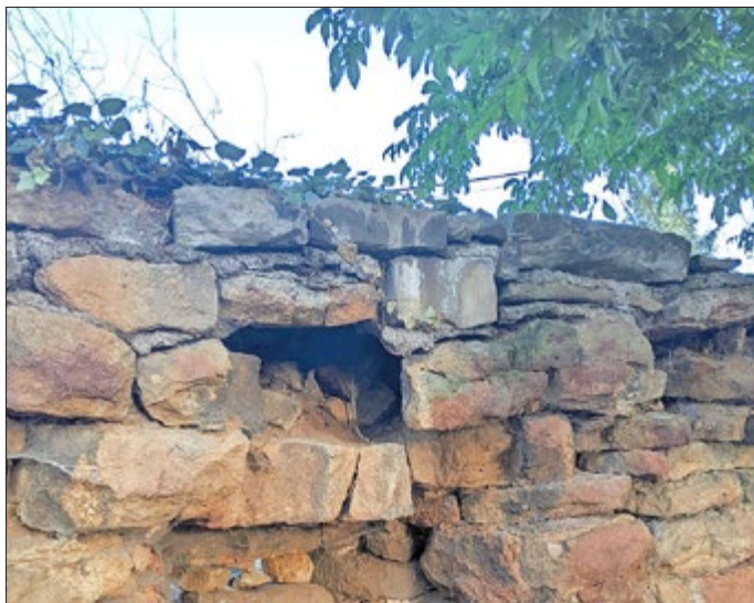
Zustand vor der Sanierung
