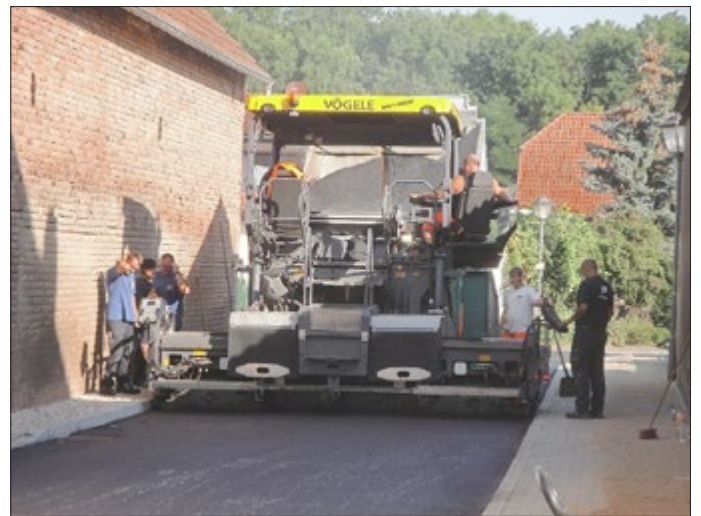
Sanierung Rettbacher Straße
