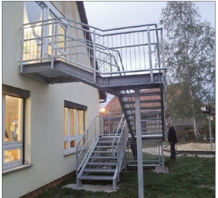
Sanierung Kita „Sonnenschein“
