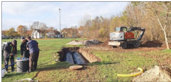
Einbau der Zisterne am Sportplatz
